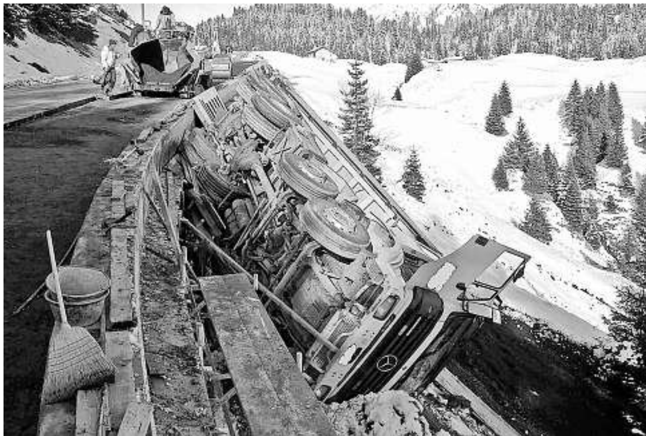
In Schräglage: Der Lastwagen ist glücklicherweise gleich unterhalb der Stützmauer zu liegen gekommen.
